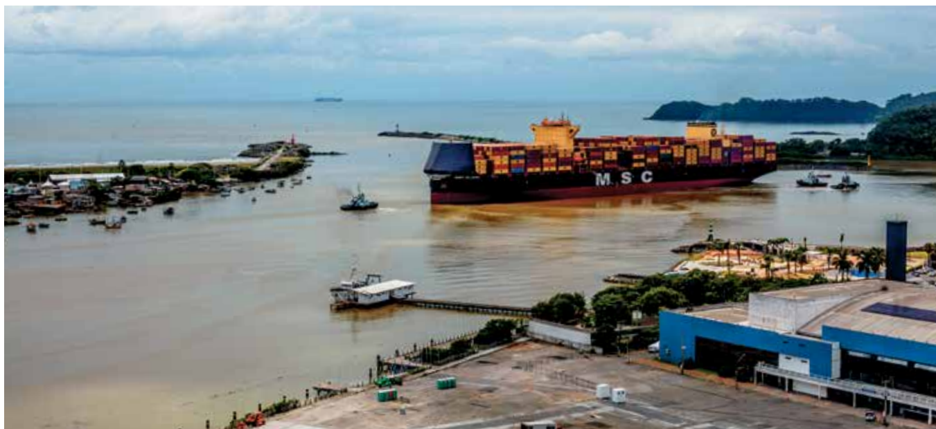
GIRO DE NAVIO DE 336 METROS NA BACIA DO SACO DA FAZENDA
